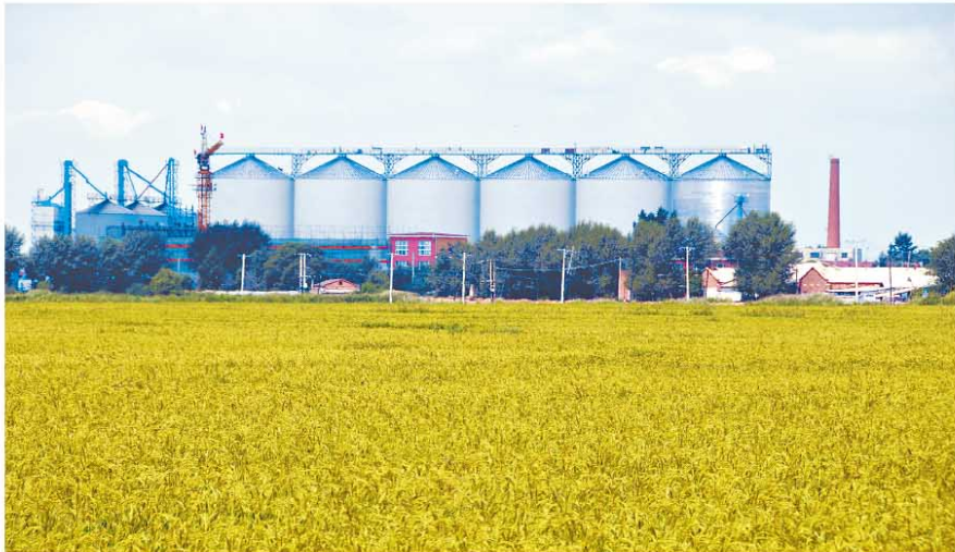
五常米业新建钢板恒温仓
